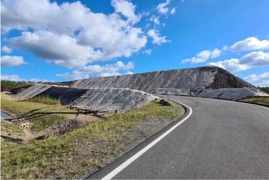
Tijdelijke opslag zout Gorleben; bron BGE
